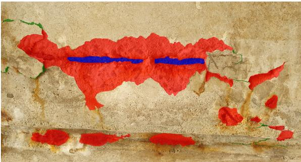
Abbildung 5: Segmentationsmasken an einem Stahlbeton-Bauteil mit mehreren Schadstellen. Abplatzungen sind in rot dargestellt, Risse in grün, freiliegende Bewehrung in blau. Quelle: RUB
